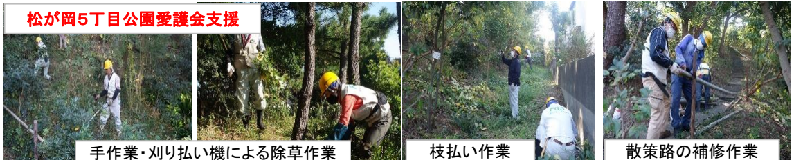
手作業・刈り払い機による除草作業
